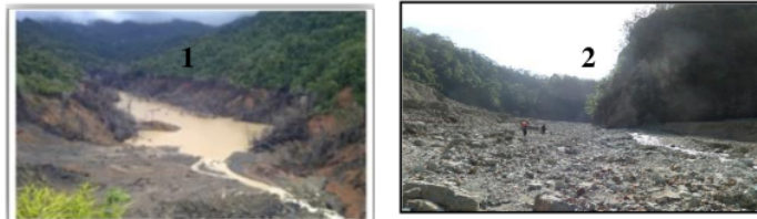
Gambar 3. Kondisi Aliran debris Pasca Runtuh Bendungan Alam
